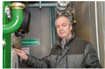
Die Biogasanlage macht unter anderem aus Gülle, Obst- und Gemüseabfällen Strom und Wärme
