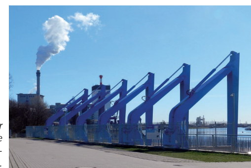
Weithin sichtbar ist die blaue Rechenreinigungsanlage.
