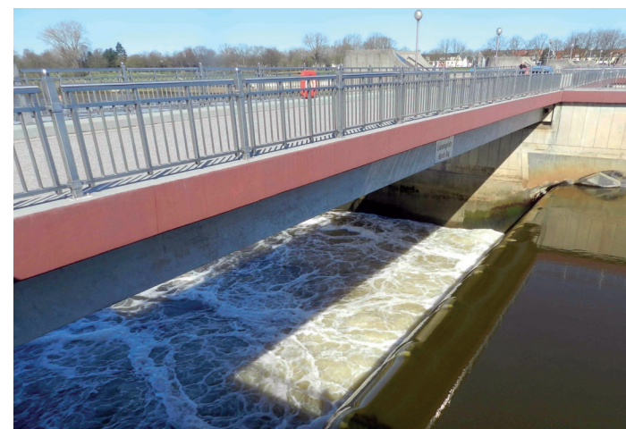
Blick in ein Wehrfeld. Hier fällt das Wasser der Mittelweser gerade bei Tidehochwasser in die Unterweser.
