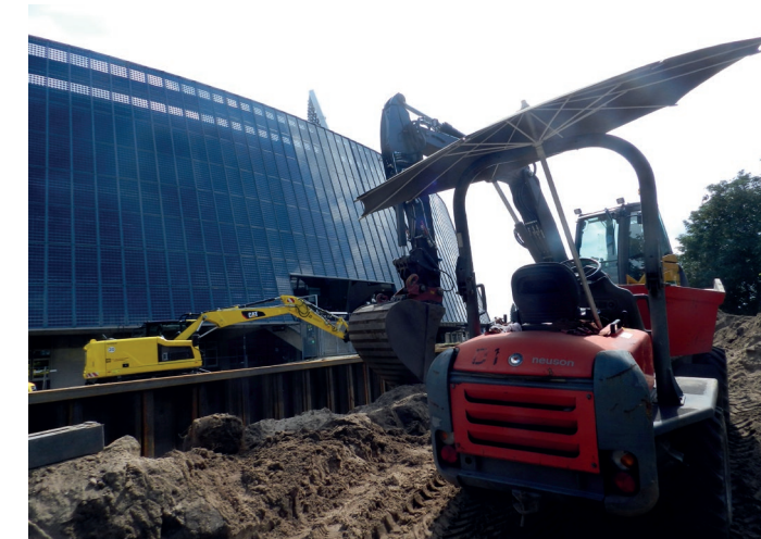
Tatort August 2016: Die Spundwand vor dem Weserstadion wird eingesetzt. Gegen die Hitze hilft dem Baggerfahrer ein Sonnenschirm. Der grüne Deich ist während der Umgestaltung unter den Sandmassen verschwunden.
