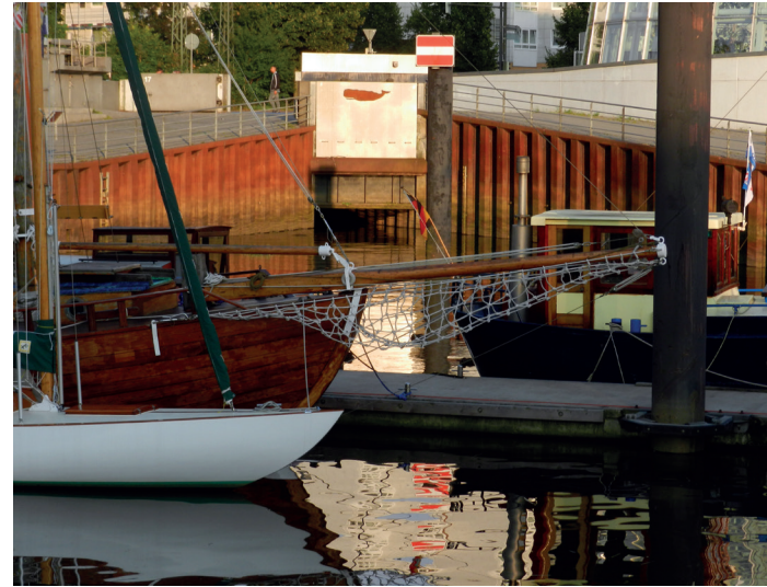
Nach der Bahnuntertunnelung tritt die Aue im Vegesacker Hafen versteckt ans Tageslicht.
