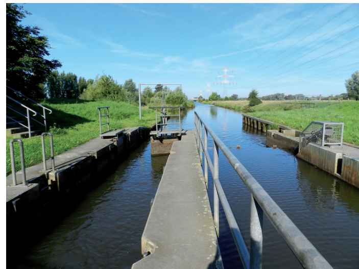
Der Warturmer Stau - mit Kanuschleuse - regelt die Wasserstände der Ochtum. Bis hierher kann es Tidenbewegungen geben.
