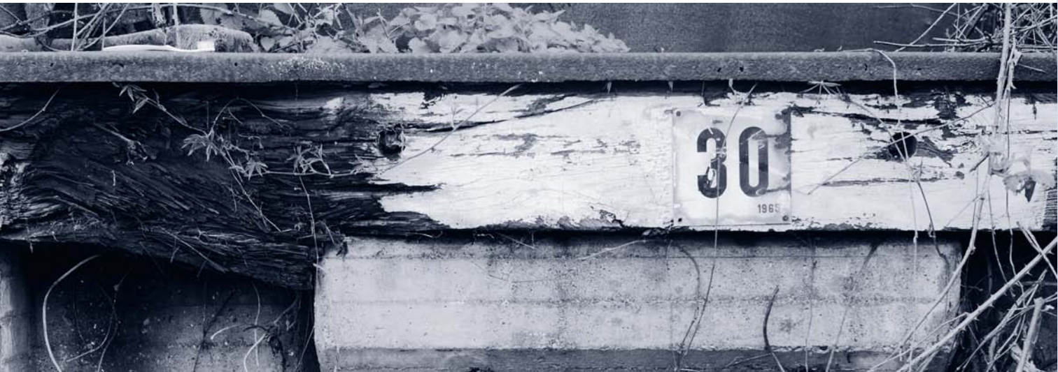
| Prellbock des Autoverlagegleises 21 im Bahnhof Köln-Deutz 2016 Foto: J. Römer |
